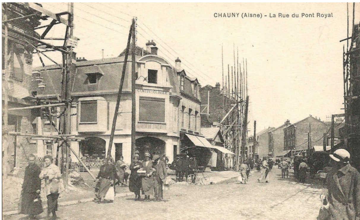
Vue de la Rue du Pont-Royal (actuellement rue de la République) en reconstruction. On aperçoit à gauche le toit en triangle de la bijouterie Jovet à proximité des échafaudages. On distingue aussi le fronton de l'ancienne charcuterie Contis-Olivier encore visible de nos jours.
