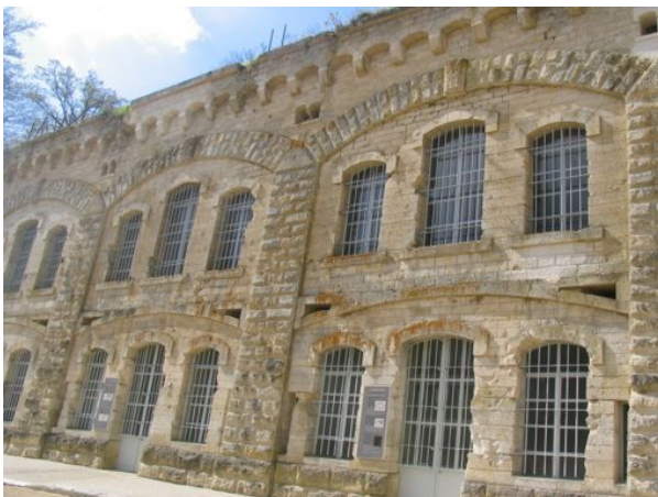
Magasins pour les provisions, logements des soldats et des officiers, le fort était une petite ville invisible de l'extérieur.
