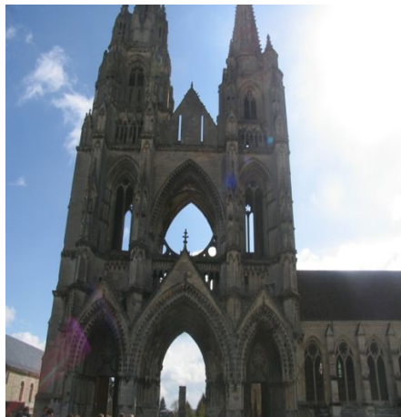
La façade de Saint-Jean-des-Vignes
